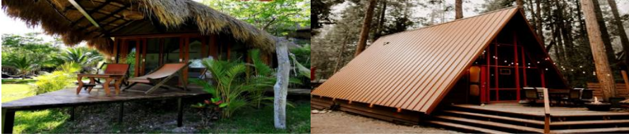
Resim 5. Baraka ve “A Frame” Kabinler
