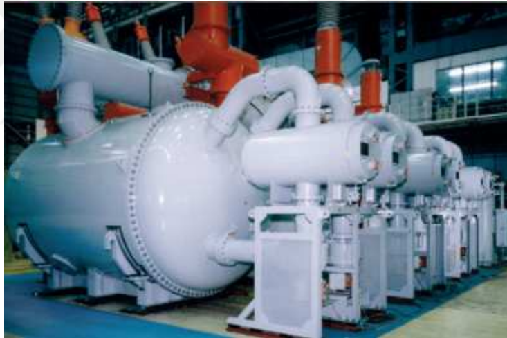
řekil 1.2. SF6 gazlı 275 kV-300 MVA kapasiteli dnyanın ilk byk GYT'si (Yanari, 2004)
