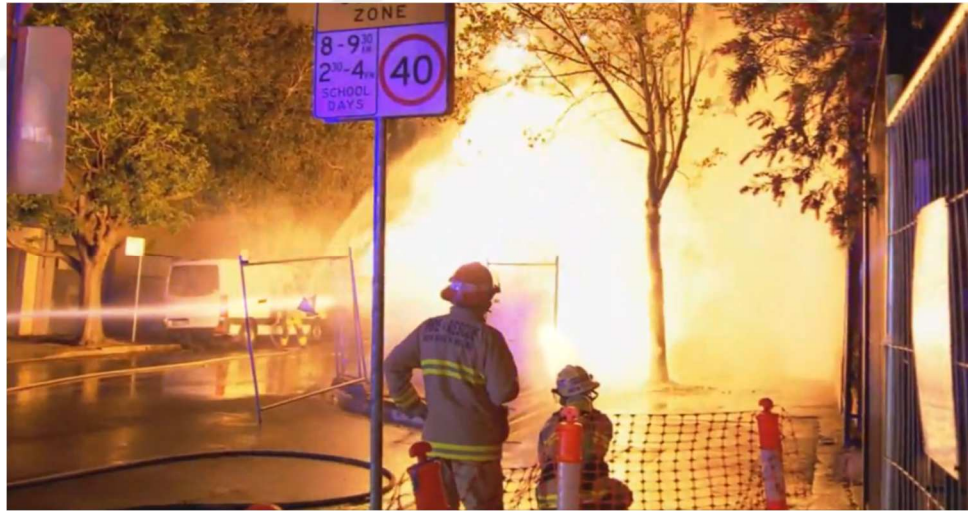
Şekil 1.1. Yağ yalıtımlı transformatör yangını (Holman, 2013).
